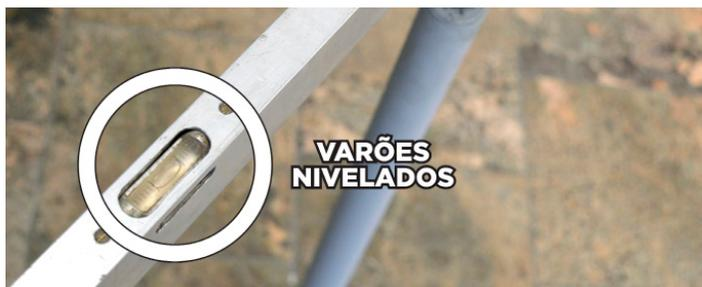
Fig.15 - Varões nivelados
