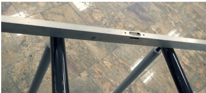
Fig.12 - Rêgua de nível sobre os varões
