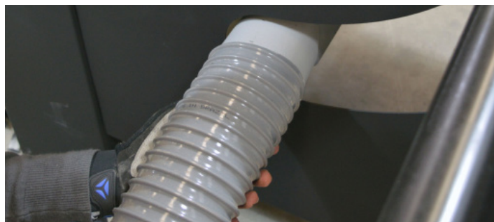
Fig.72 - Mangueira instalada atrás da máquina
