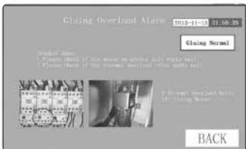
Imagem 15 - Alarme de Sobrecarga de Colagem
